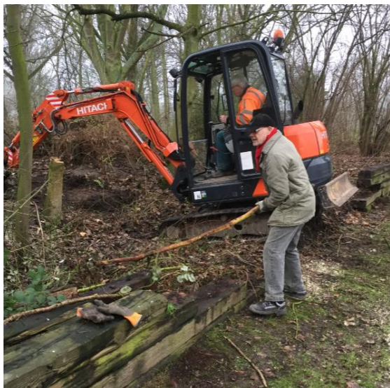
Nieuwbouw vergt vele werkzaamheden.
